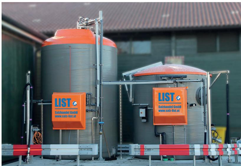
Erzeugung von klarer Sole durch ein spezielles Filtersystem um Probleme bei Solesprühfahrzeugen zu vermeiden
